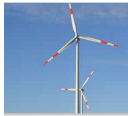
Ein Windkraftwerk liefert Strom für bis zu 1500 Haushalte in Deutschland.
